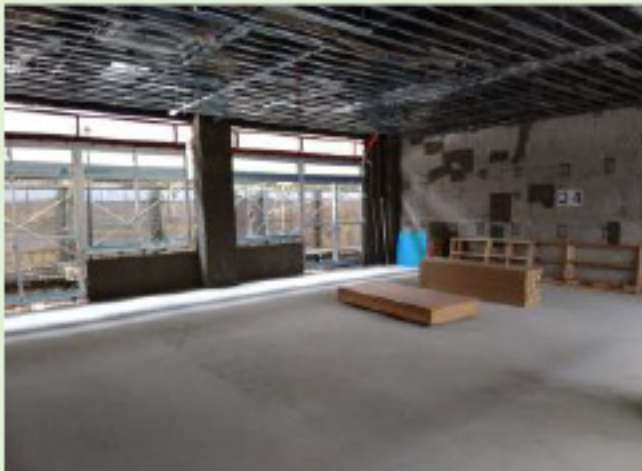
3階教室天井下地組状況
