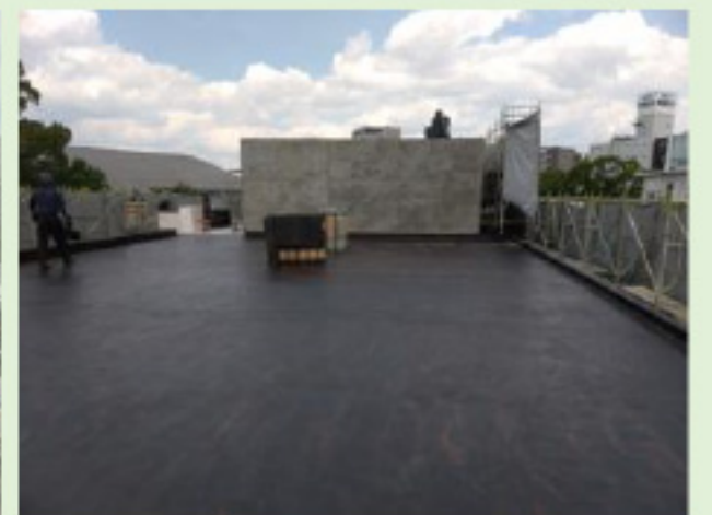
屋上プライマー塗布状況
