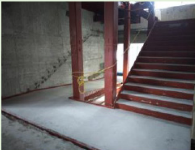
西階段コンクリート打設後状況
