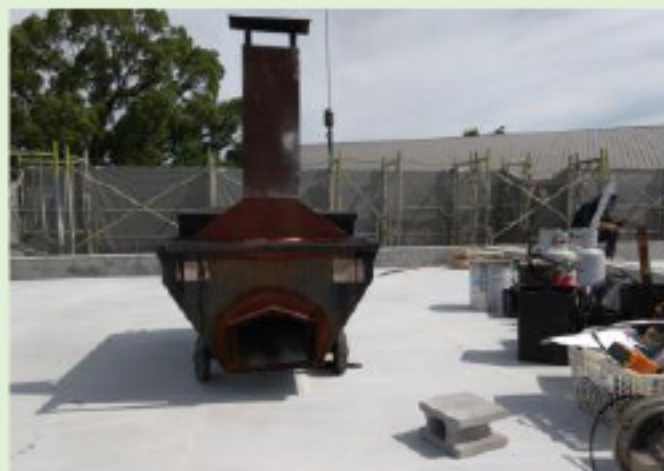
屋上アスファルト溶融釜設置状況
