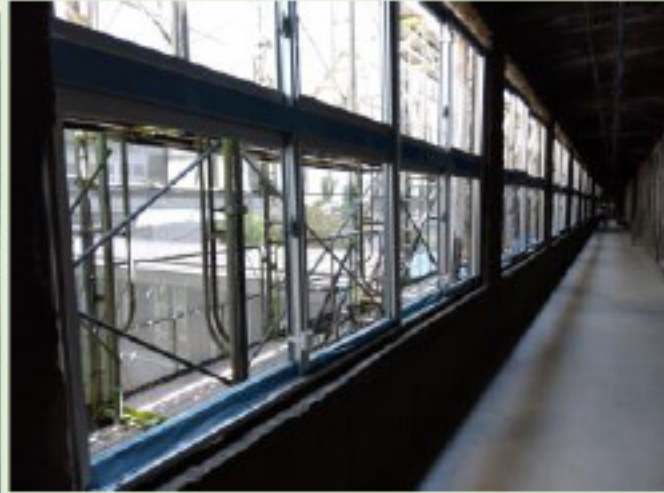
3階廊下サッシ取付状況
