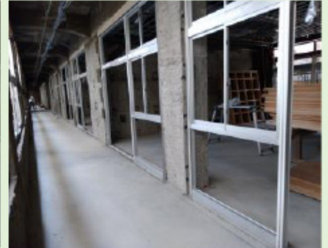
3階洋室・廊下間仕切設置状況
