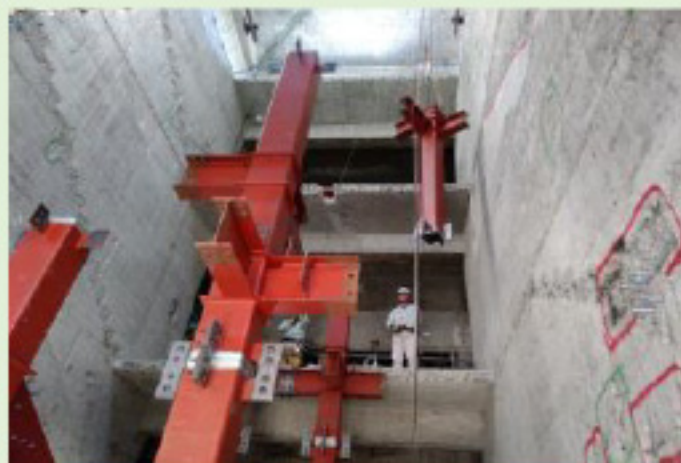
②柱吊り込み状況
