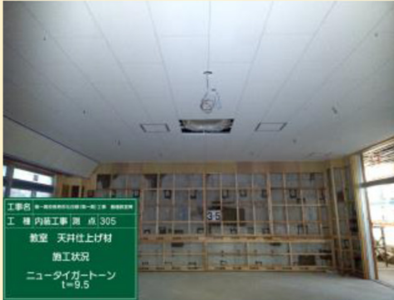
3階教室天井ボード施工状況
