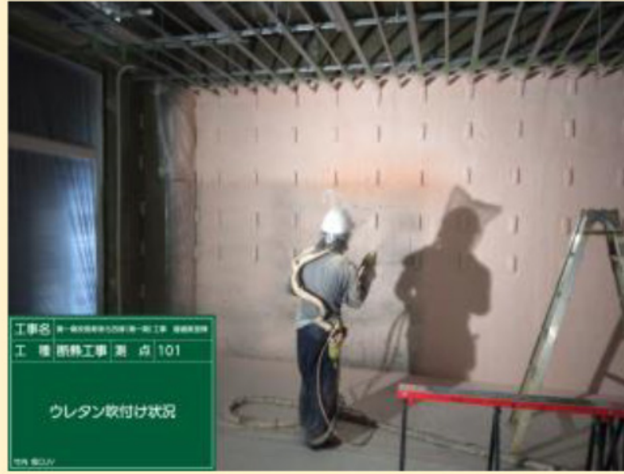
1階教室外周部ウレタン吹付状況
