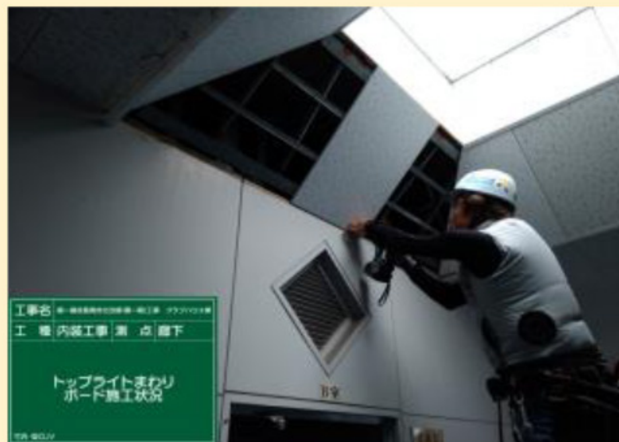
クラブハウスボード張替状況
