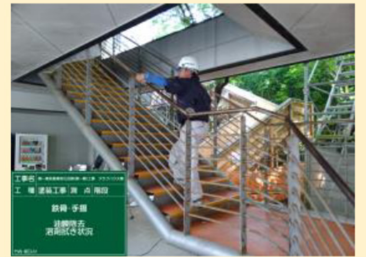
油膜除去（溶剤拭き）、研磨紙摺り
