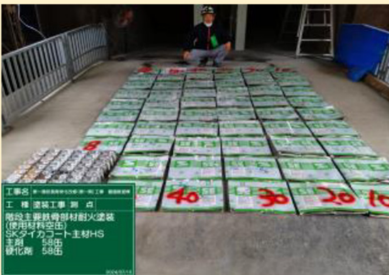
塗料使用量確認状況
