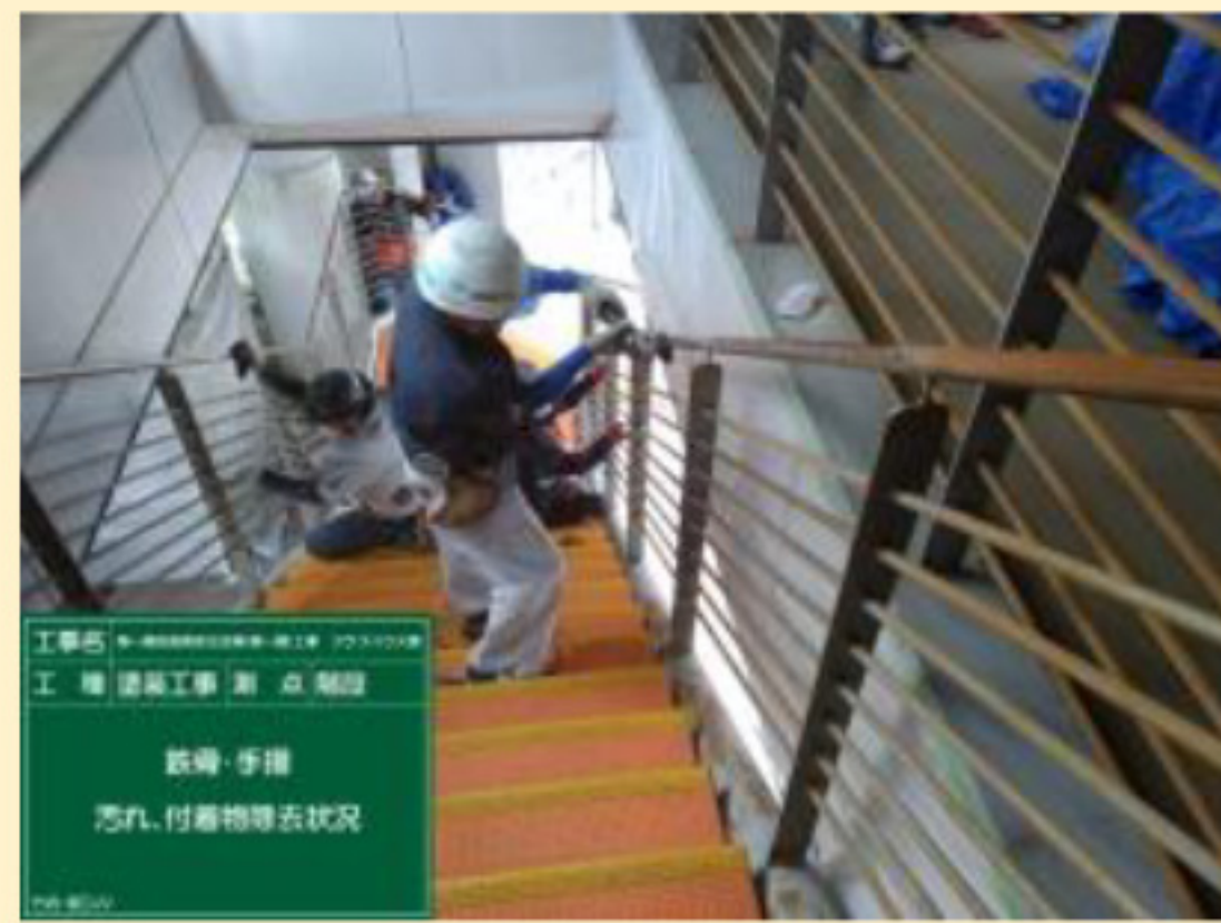
既存塗膜・汚れ・付着物除去
