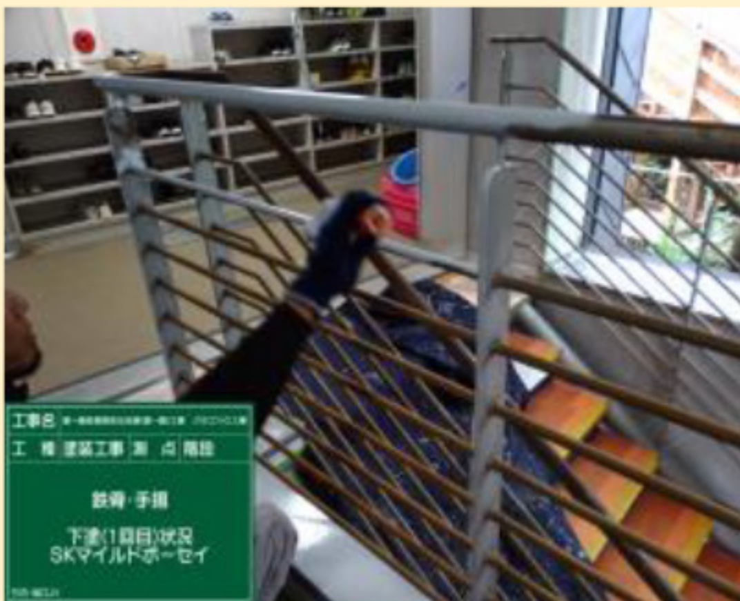
下塗り（錆止め塗料）1回目
