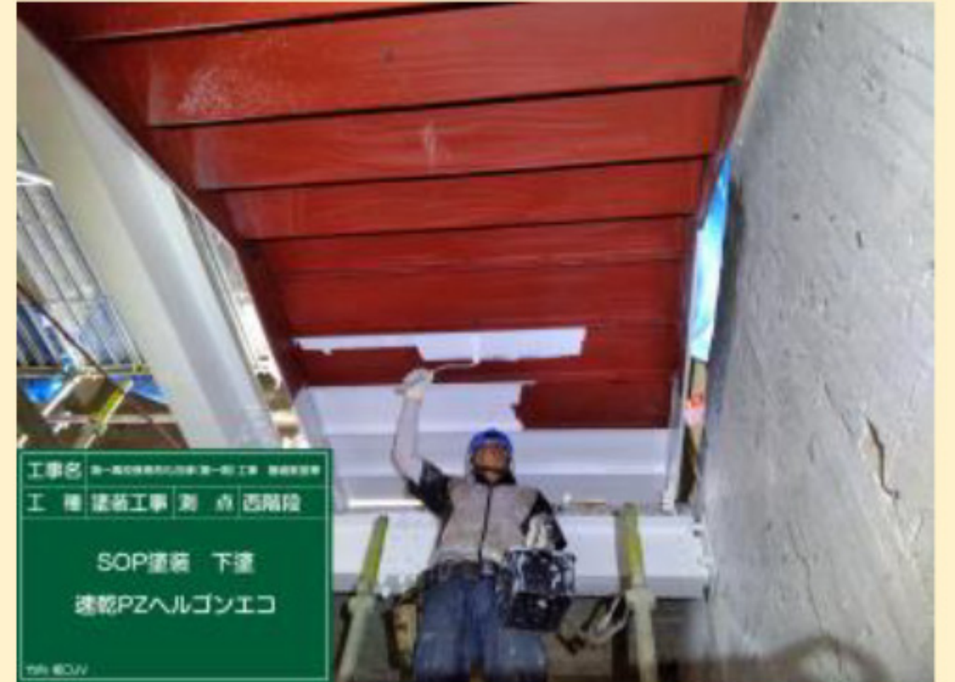
鉄骨階段塗装状況
