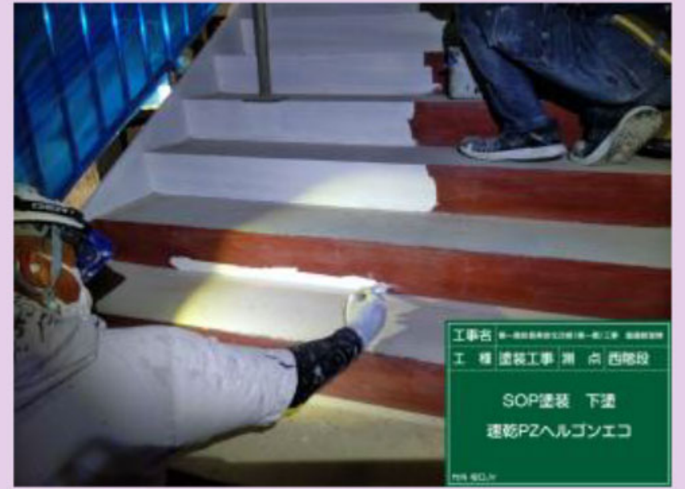
鉄骨階段蹴上塗装状況
