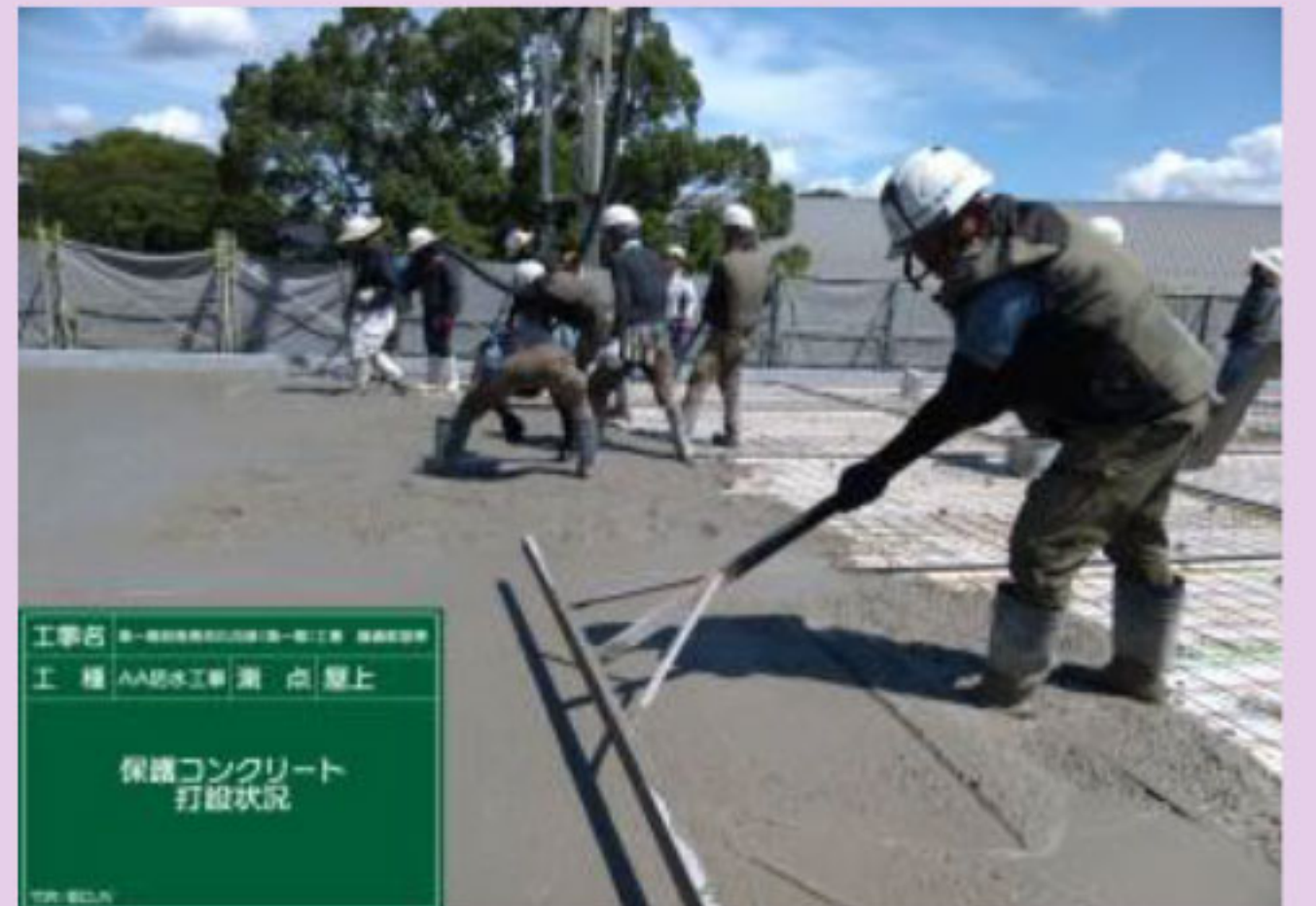
屋上防水保護コンクリート打設状況
