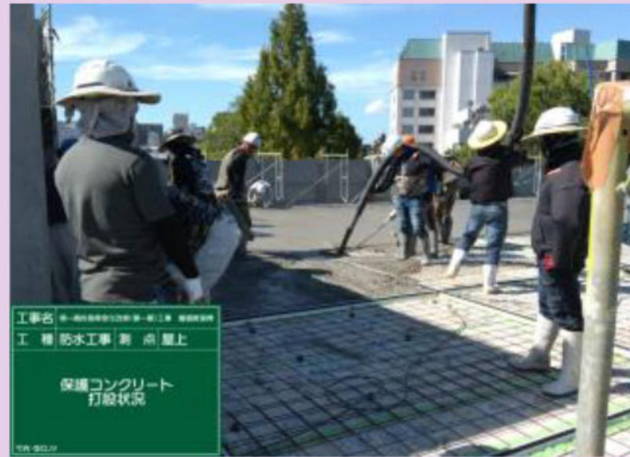
屋上防水保護コンクリート打設状況
