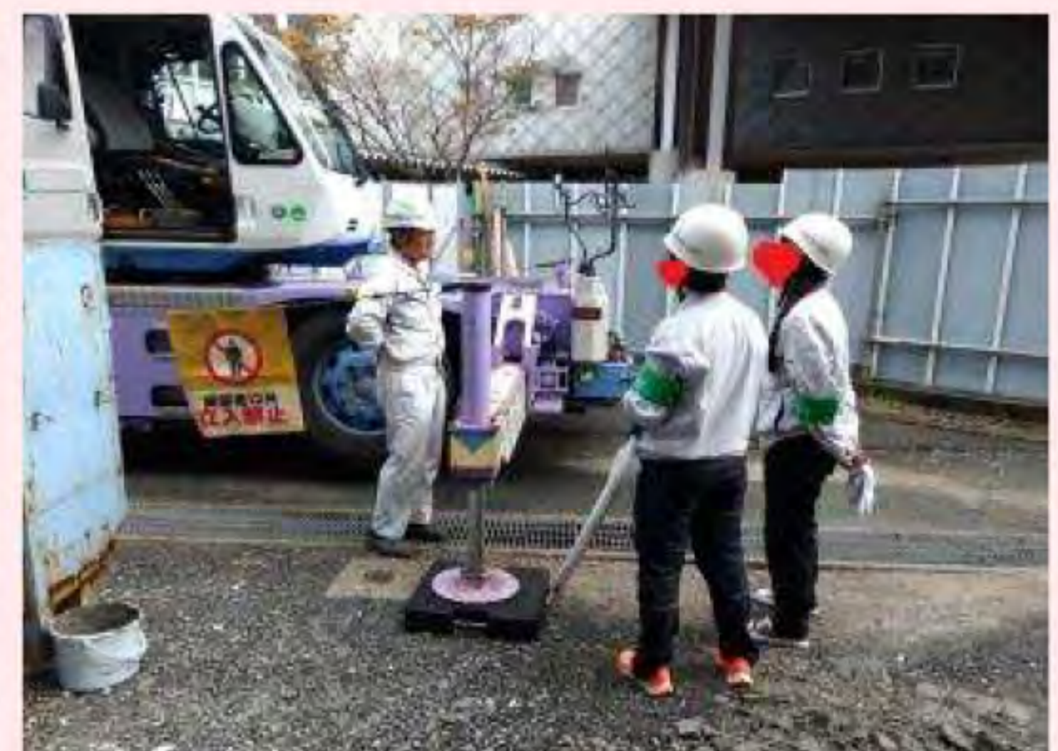
クレーンについてオペレータさんより
