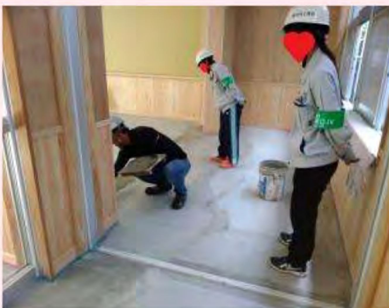
左官工事床モルタル塗りを見学
