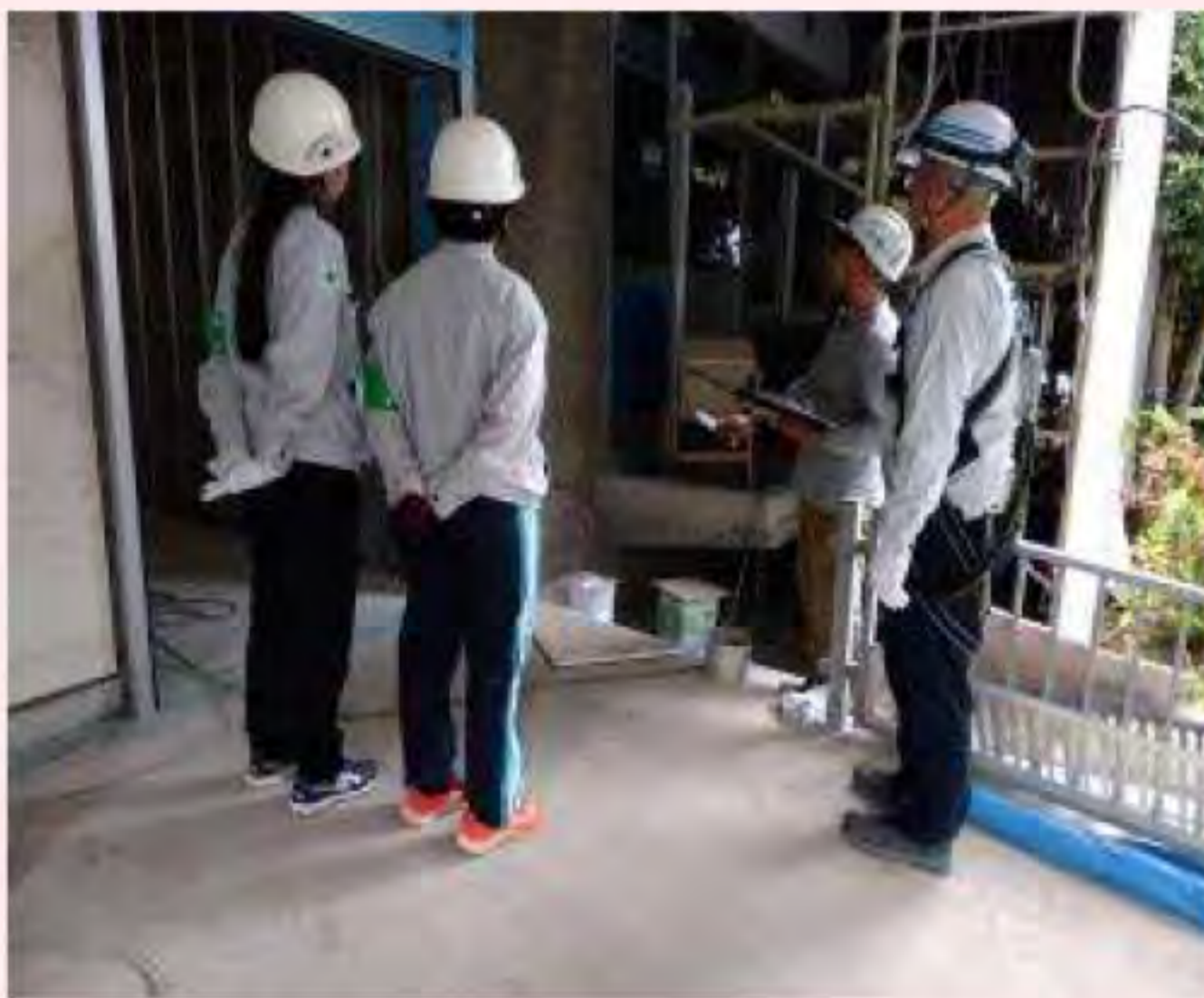
中性化対策工事について学び、外壁の補修体験
